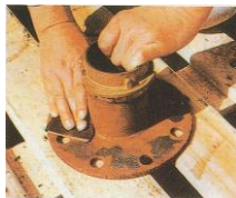
ワイヤーブラシなどで浮き錆を取り除きます。
