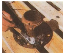
油汚れを取り除き、ソラックスを塗布します。
